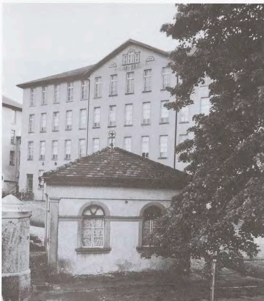
Fabrikschulhaus: Im Vordergrund steht das ehemalige Wächterhäuschen der Spinnerei Kunz in Windisch, das als Fabrik-schulzimmer diente und in dem zeitweise über 100 Kinder in mehreren Schichten von einer einzigen Lehrperson unterrichtet wurden! Im Hintergrund ist das vierstöckige Fabrikgebäude zu sehen.
